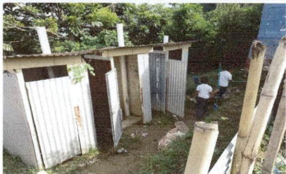
Foto 1: Los 3 sanitarios necesitan reparación ya que están hecho de pleibol y se está quebrando sus paredes y las puertas no cierran bien.
