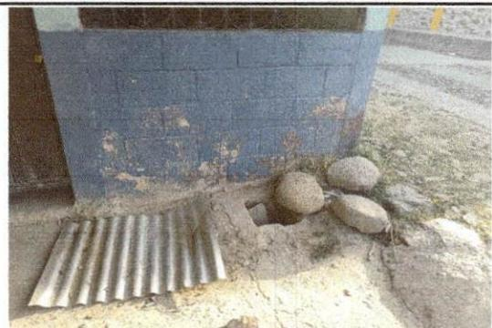
Foto 3: con la corriente de agua se ha levantado la tapa de la caja de drenaje que conduce el agua de la pila de la cocina
